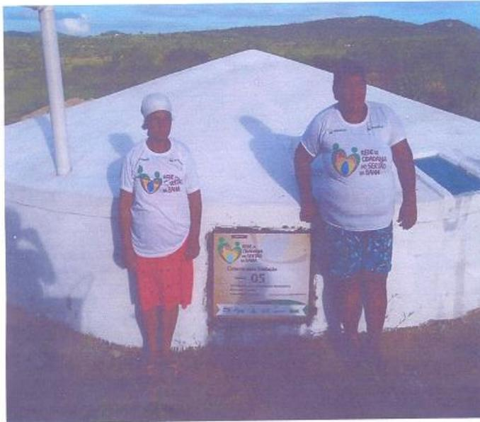
Declaro que a associação supramencionada foi beneficiada pelo Programa Rede de cidadania no Sertão da Bahia , com uma Tecnologia Social Cisterna de 52 mil litros, em perfeitas condições de uso, com os seguintes itens devidamente instalados: Calha completa (com tubos e conexões), telas de proteção e coador, uma bomba elétrica para retirada de água, um cadeado, uma tampa, uma placa de identificação.
